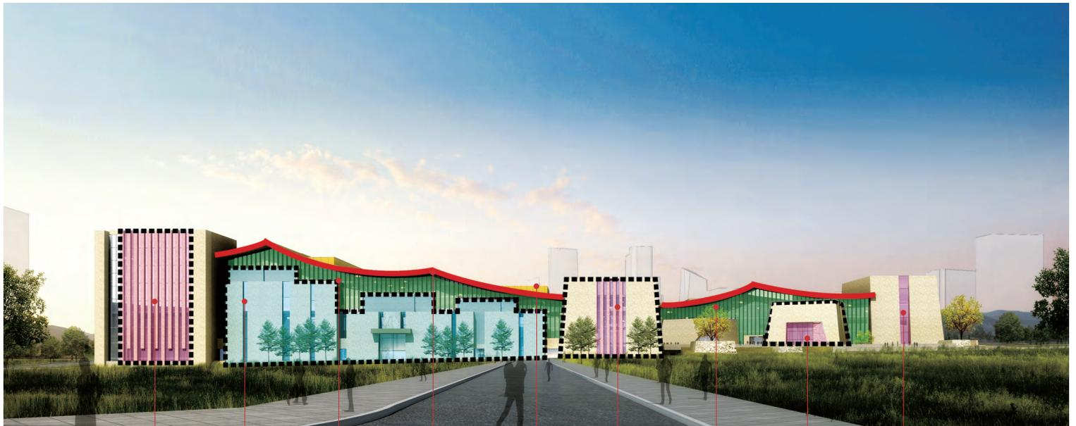
办公区均匀开窗采光 交通设备用房较少开窗 金属格栅幕墙竖向遮阳 连续金属屋顶水平遮阳 中庭及庭院采光通风顶 会议区竖向均匀开窗 休息交通厅竖向遮阳 入口及门厅虚实对比 交通设备用房较少开窗
