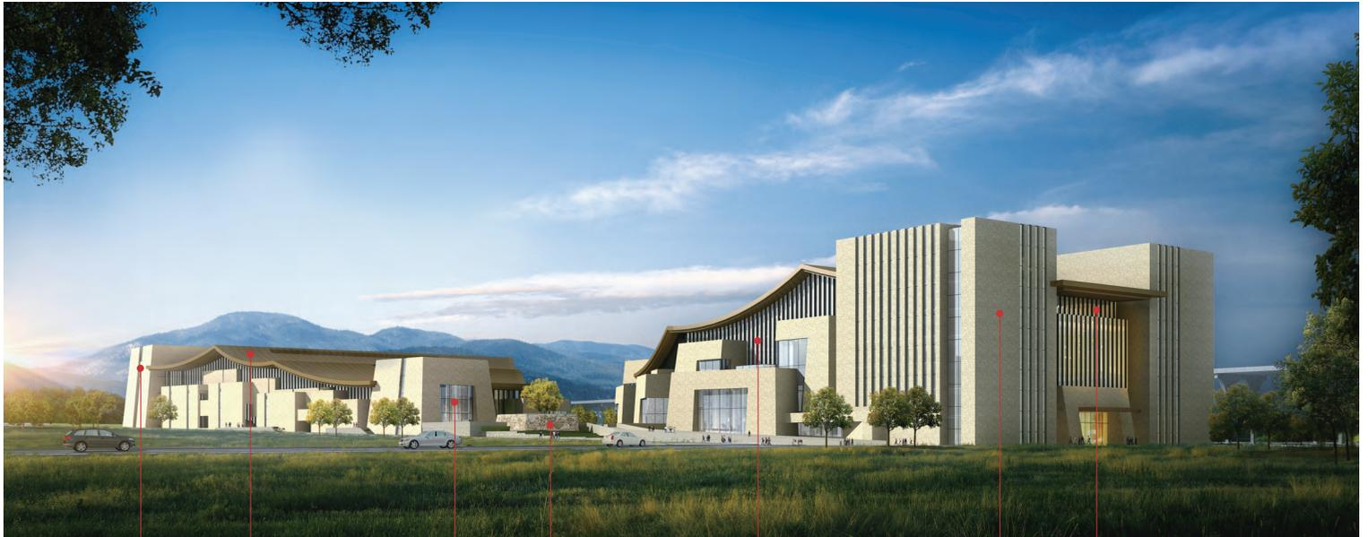
米黄色石材 古铜色金属屋顶 玻璃幕墙 浮雕装饰 古铜色金属格栅 米黄色石材 玻璃幕墙
